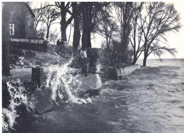
Hochwasser am Parnass 1976
